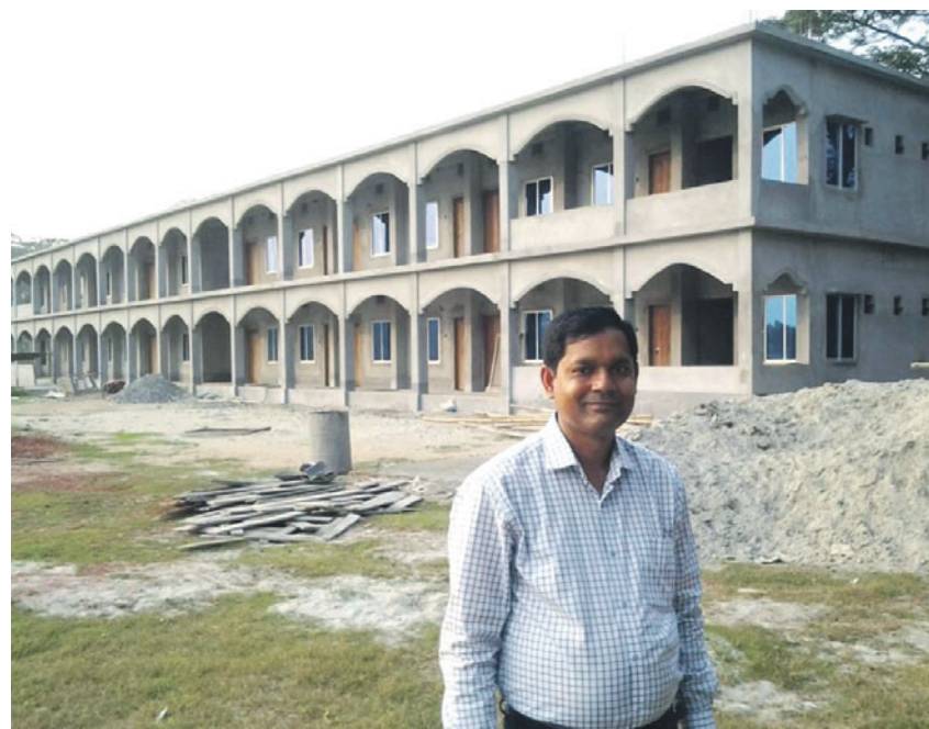
Der Rohbau der Schule in Bangladesch (Foto: ZVG)
